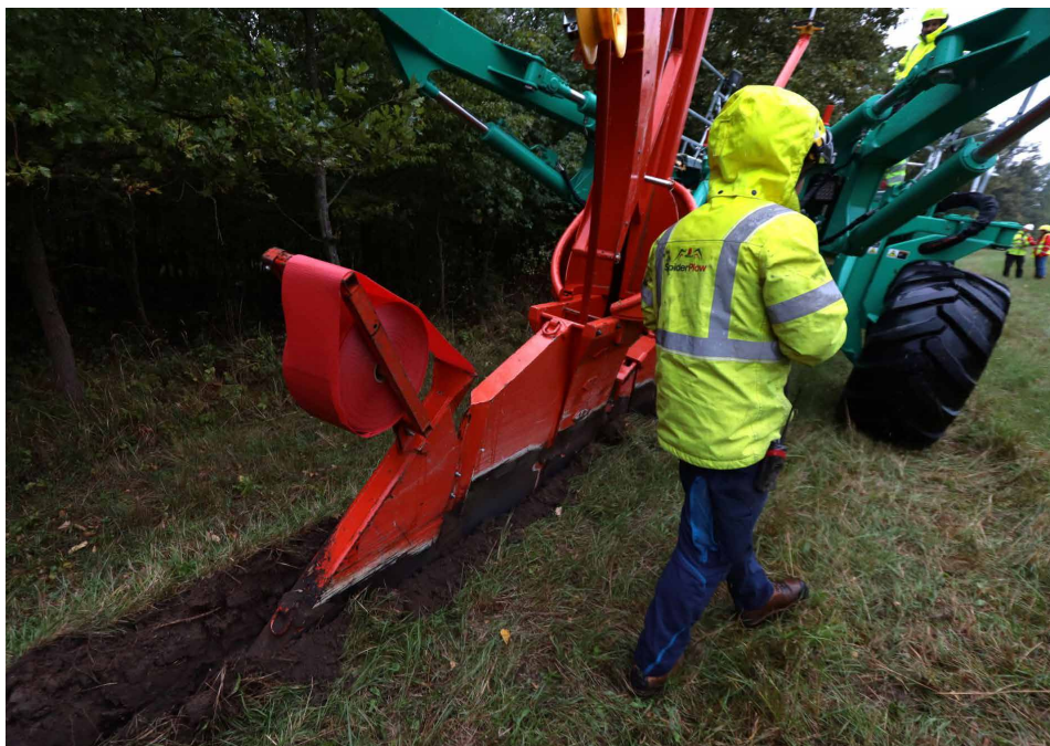
Pluhování kabelů v CHKO Soutok
